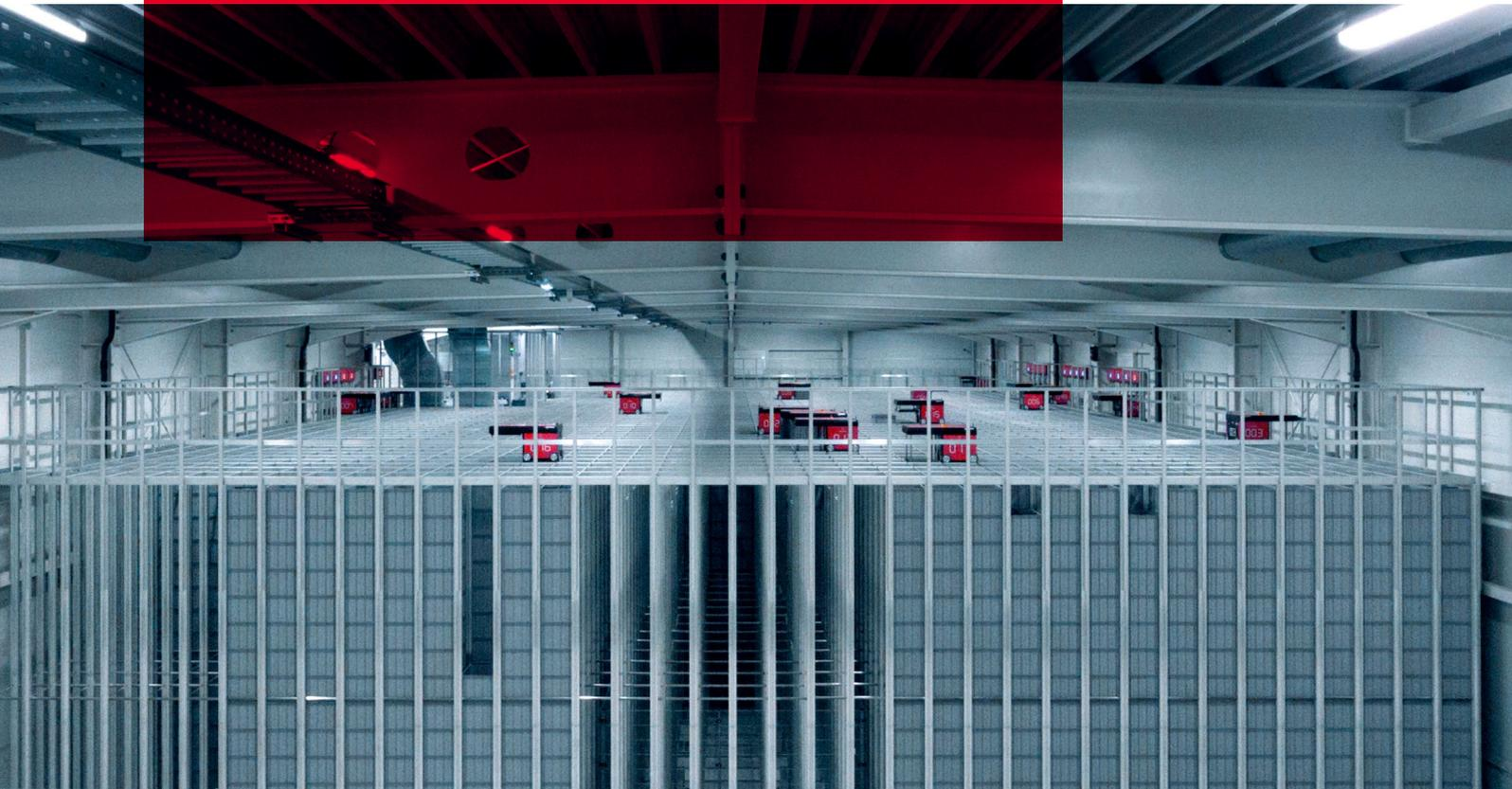
Das AutoStore Aluminium-Rastersystem steht direkt auf dem Hallenboden. Über den Behälterstapeln ist das Fahr schienensystem, das sogenannte Grid montiert auf dem sich die Roboter bewegen.
